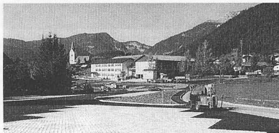
Mit dem Bau des Großparkplatzes bei der Grimming-halle wurde begonnen.
